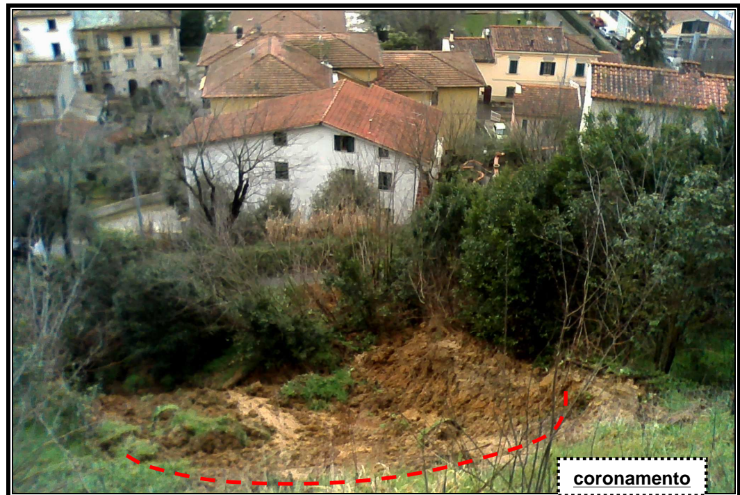
Foto n° 3 – coronamento di frana
