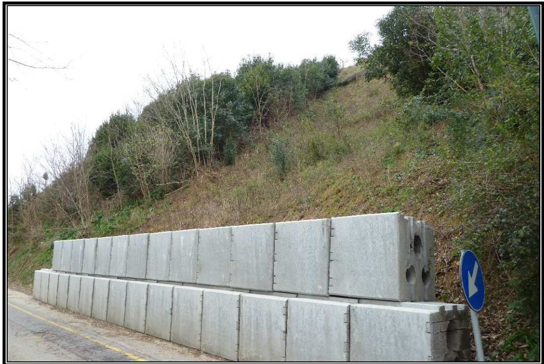
Foto n° 9 – particolare dell'opera di contenimento in geoblock eseguita in conseguenza del primo evento franoso di marzo 2013
